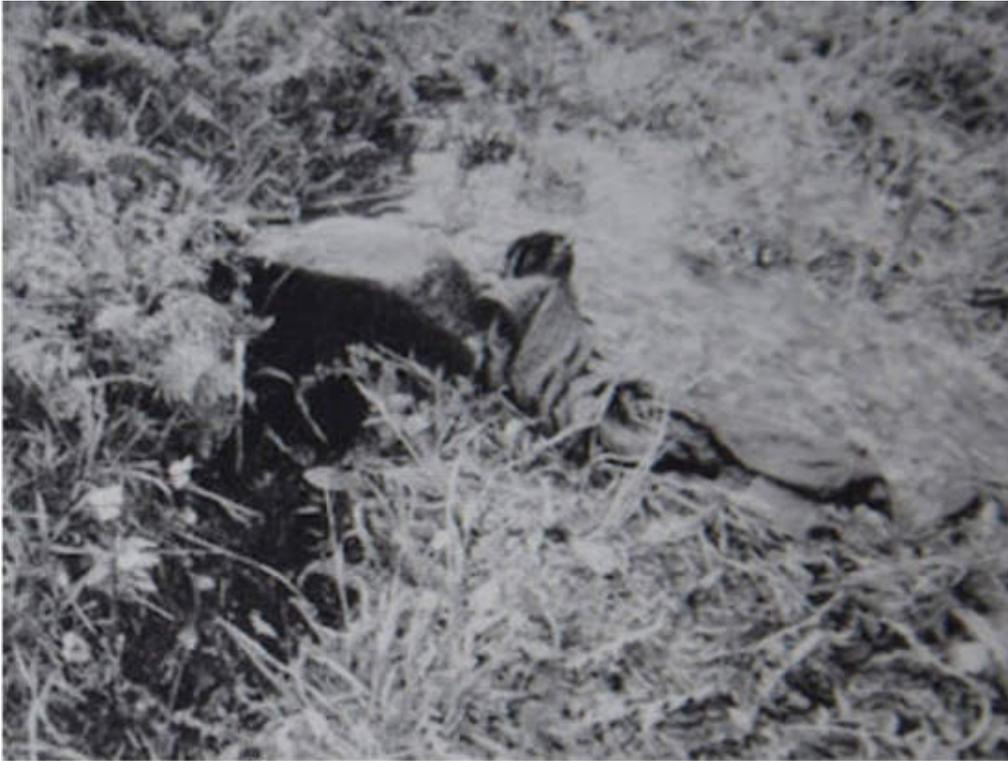
*Fig. 8 – Sölden im Ötztal. Das Wasser in dem Kanal wird mit Hilfe eines flachen Steins abgedämmt und mit ein paar Lumpen beim Ausfließen reguliert.*
