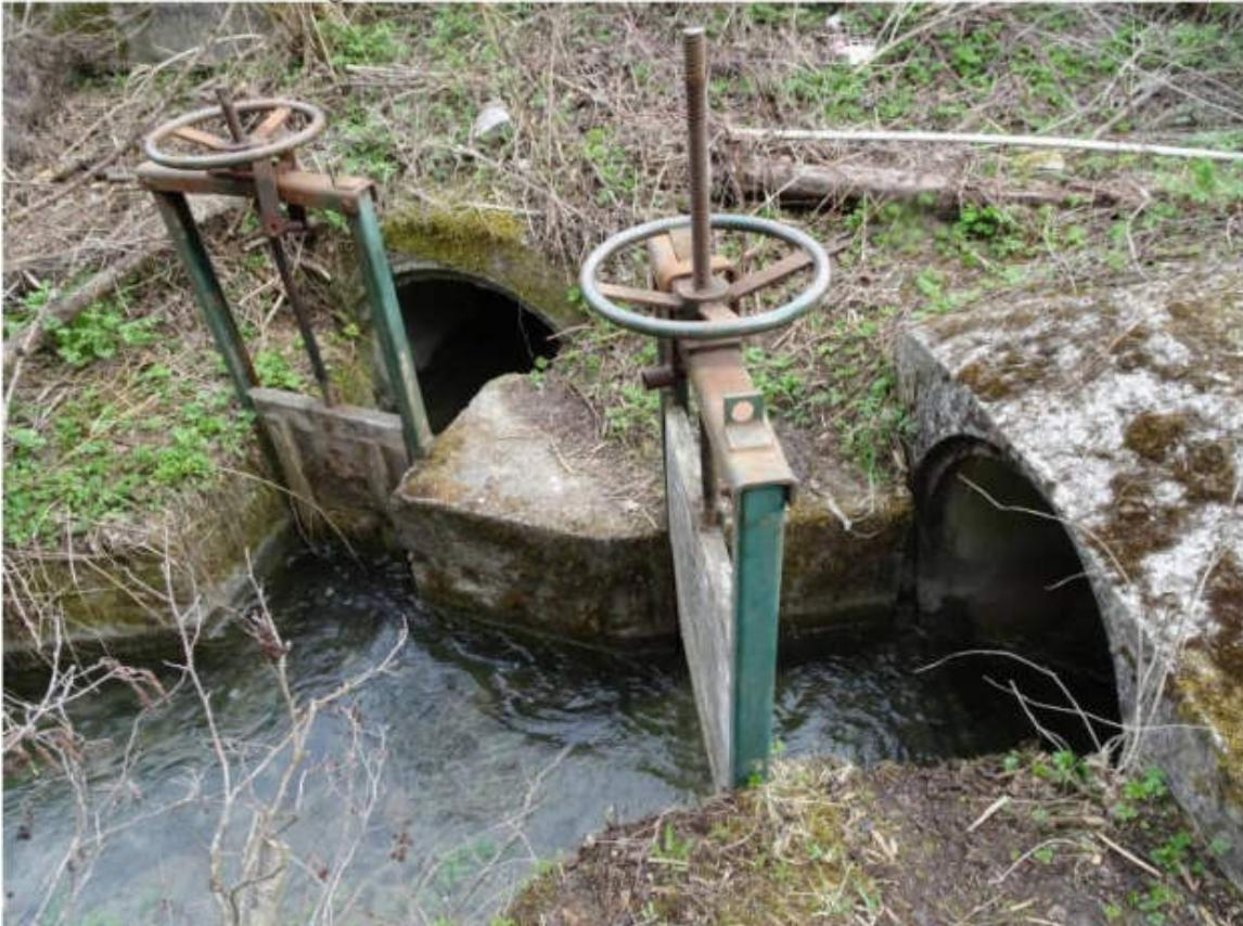
*Der linke Schieber öffnet dem Wasser den Weg in den Haiminger Mühlwaal, der oft auch die Aufgabe des Feuerwaals zu erfüllen hatte, da er quer durch das Dorf zog und noch zieht. Der rechte Schieber öffnet/schließt den Weg in den Tragwaal in Richtung Osten.*
