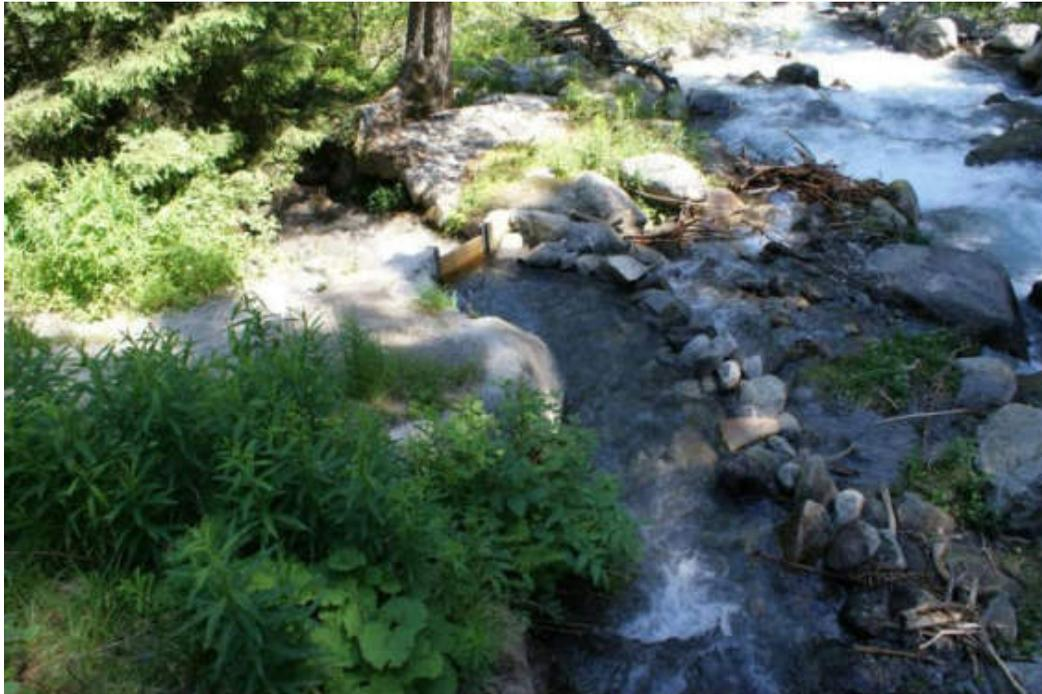
Mai 2010. Die Einkehr des Arzwinkel-Waales am Horlachbach in Stuiböbele erfolgt mit Hilfe von Steinen, die das Wasser zum Kanal leiten. Eine altbewährte und einfache Methode.
