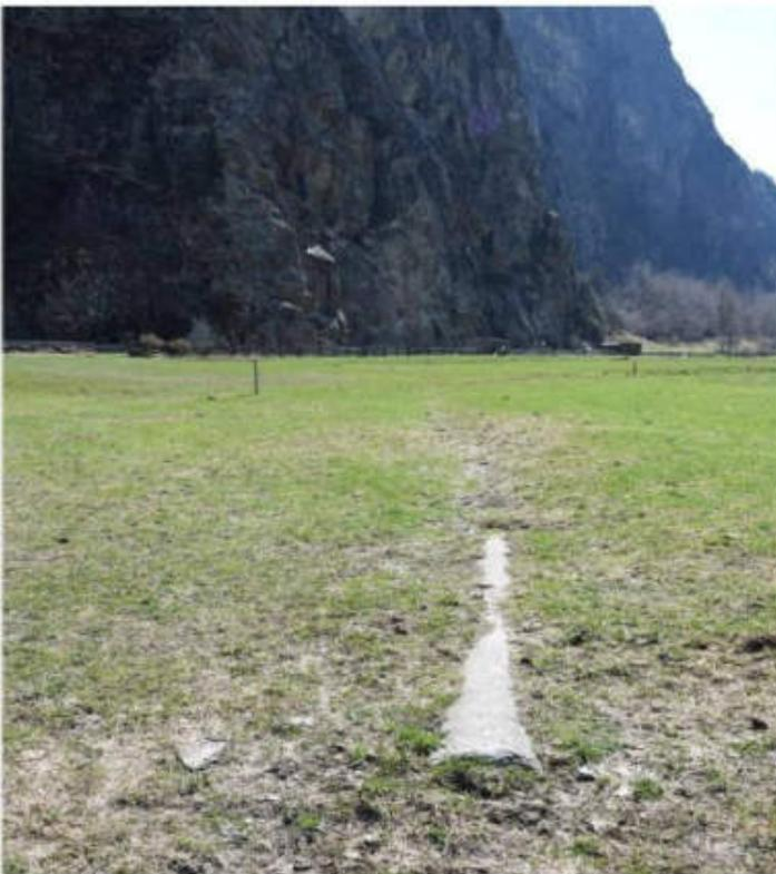
*Auf dem Weg in Richtung Grieser-Waal findet man eine kleine Dole, die zur schadlosen Überquerung des Runst-Waales mit den Landmaschinen gedacht war.*
