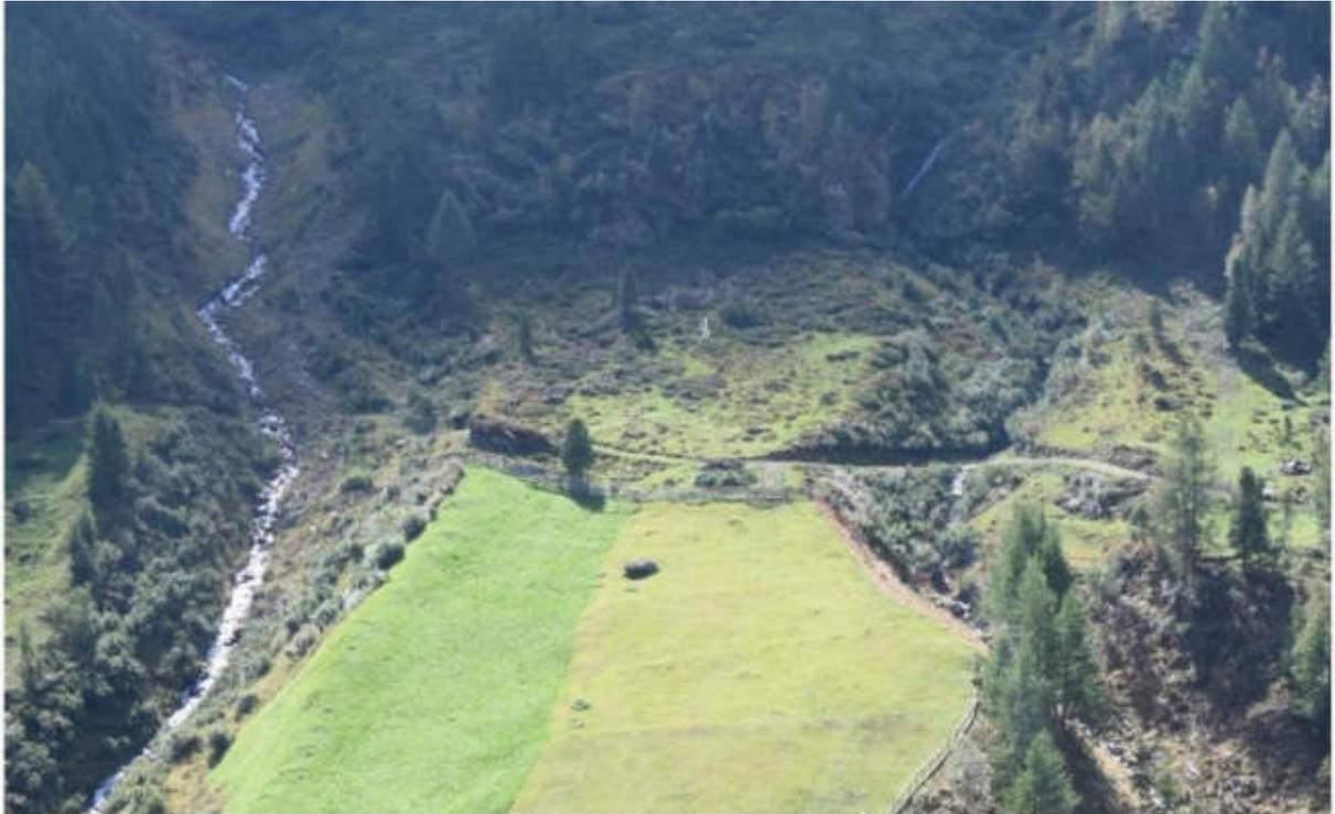
*Die beiden Hauptwaale verlaufen entlang der Grenze der Mähder auf der rechten Seite und in der Mitte auf der Längsachse.*
