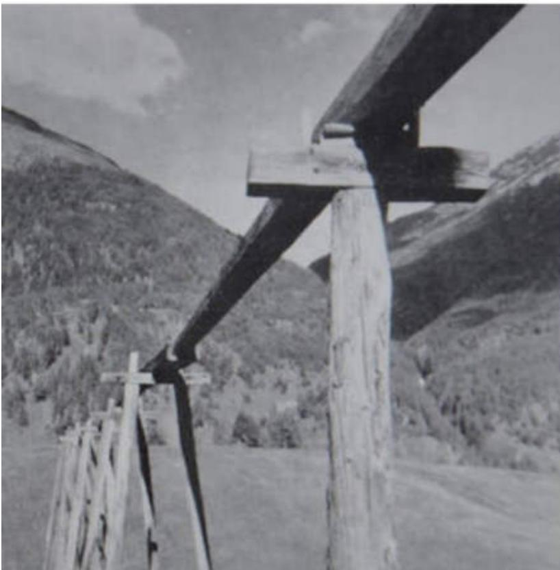
*Fig. 6 – Sölden im Ötztal. Die nach oben offenen Wasserleitungen werden mit geringem Gefälle auf hohen Holzstelzen quer über die Niederung geführt.*
