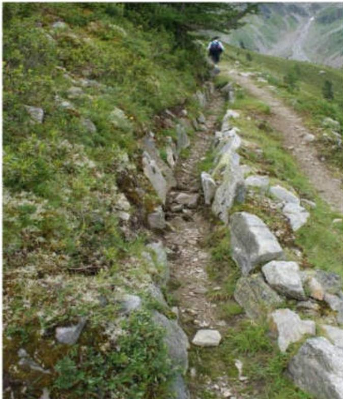
*Bei einem der beiden größeren Steingerölle wird gezeigt, wie das Problem der Waal-Leitung gelöst werden kann: mit einer Kandl, die auf den Felsblöcken liegt und mit trockengemauerten Fundamenten stabilisiert wird.*
