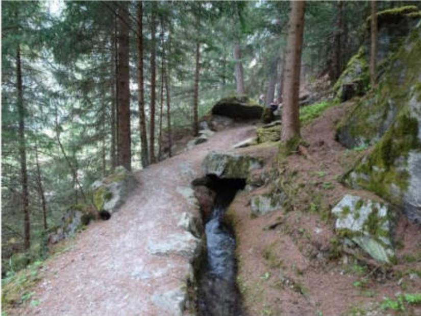
*Absicherung des Waales mit einer Dole. Eine Dole wurde gebaut, wenn der Waal eine Straße oder eine Fuhrweg kreuzt, oder in diesem Fall als Schutz gegen Steingeröll. Steine können den Waal schwer beschädigen und in Folge gefährliche Muren verursachen.*
