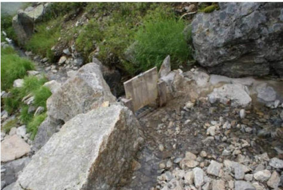
*Mit den einfachsten Mitteln (mit Steinen) und mit einem hölzernen Schieber wird der Funduswaal am Fernerbach eingekehrt. Jetzt ist der Schieber offen, damit 10 l/s in den Waal fließen können (Ausnahmegenehmigung der TIWAG).*
