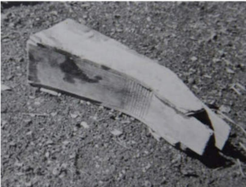
*Fig. 12 – Sölden im Ötztal. Wenn die Rinnen im Winkel verlegt werden müssen, wird ein „Knie“ aus zusammengenagelten Brettern verwendet.*
