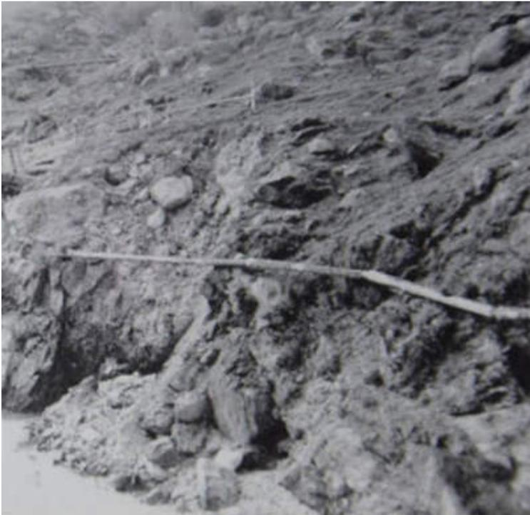
*Fig. 5 – Sölden im Ötztal. Hölzerne Wasserleitungen für Bewässerungszwecke. Die Rohre sind an den Felsen oberhalb des Rettenbaches aufgehängt.*
