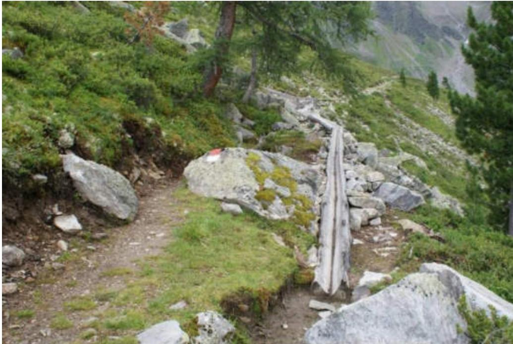
*Überquerung des ersten kleineren Steingerölls mit Kandln. Die Rinne hat einen dreieckigen Innenquerschnitt der Größe 20x16 cm, nicht wie ursprünglich einen rechteckigen oder halbkreisförmigen Querschnitt.*
