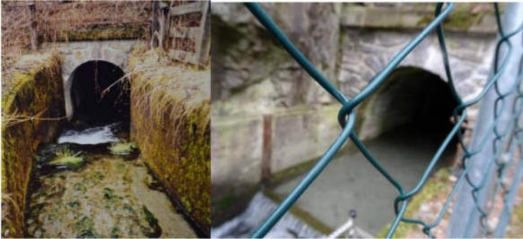
*Links: Bild des Stolleneingangs von Daniela Lammerer (1998). Rechts: Aufnahme des Stollenausgangs nordwestlich am Fuße des Amberges (2018). Der Waal besitzt eine Förderleistung von 1.350 l/s (180 cm breit, 100 cm hoch). Die restlichen 150 l/s sind Trinkwasser aus den 22 Quellenaustritten, die mit einer separaten Rohrleitung durch den Stollen und weiter nach Haiming geführt werden.*
