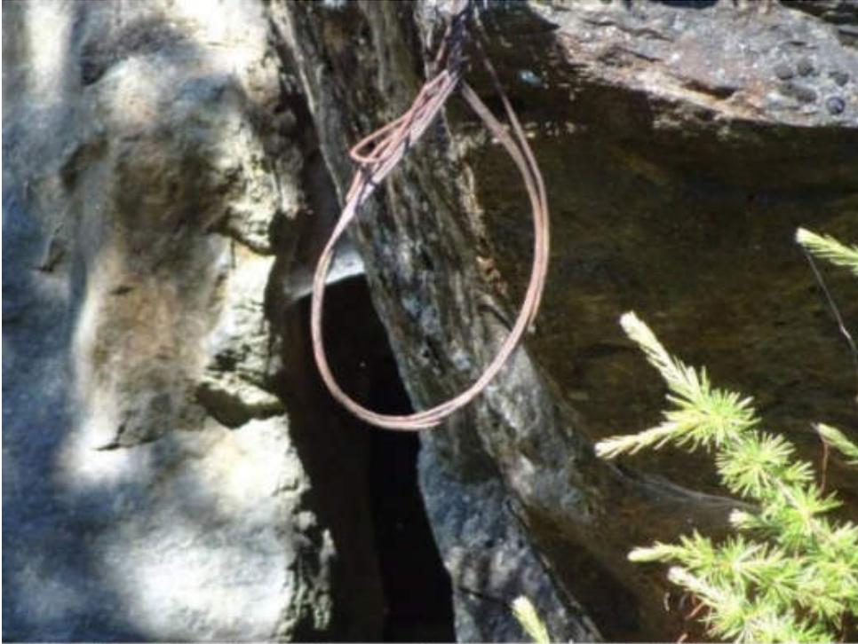
*Granbichlwaal 1: Tragschlinge aus Stahl, damit wurde ein Holzrohr des Waales am Felsen befestigt.*
