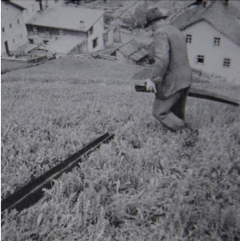
*Fig. 11 – Sölden im Ötztal. Die Rinne wird mit Hilfe einer zweiten Rinne verlängert. Diese wird von Zeit zu Zeit fächerartig in andere Richtungen umgelegt.*
