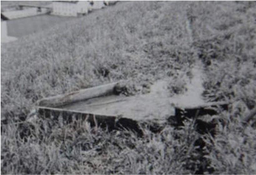
*Fig. 9 – Sölden im Ötztal. Das Wasser in dem Kanal wird mit einem Brett abgeschottet. Der trichterförmige „Fanger“ mit dreieckigem Grundriss leitet es in eine offene Holzrinne.*
