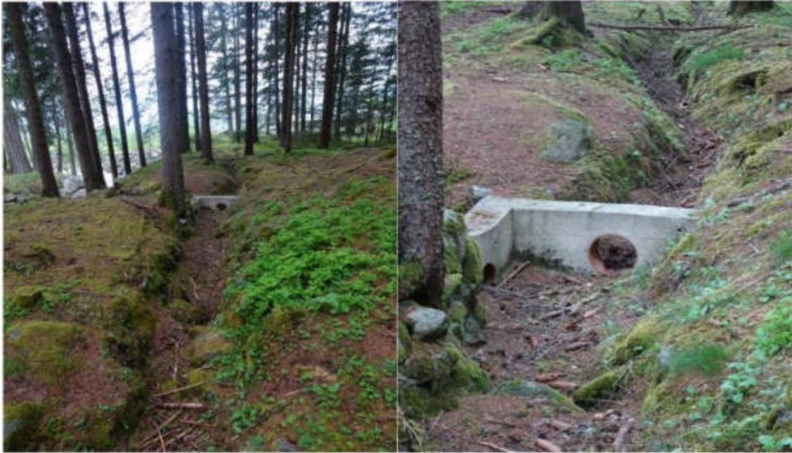
*Der Erdwaal befindet sich hier noch in einem relativ guten Zustand. Er nähert sich immer mehr dem rechten Ufer des Stuibenbachs, bis zu einer Stelle, wo sich ein Teilstöckel (Schwölller) mit Weiter- und Abkehr-Regulierung befindet.*
