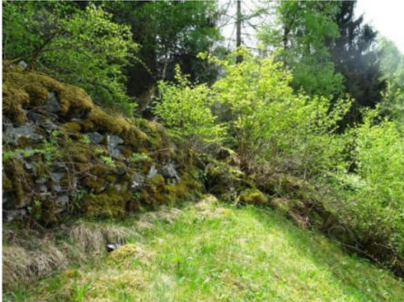
*Am Dornachwaal. Die trockengemauerte Bauweise derartiger Grenz- und Dichtwälle ist eine handwerkliche Maurerkunst, die allmählich in Vergessenheit gerät. Im Schweizer Kanton Wallis sind schon mehrfach Versuche mit der experimentellen Archäologie gemacht worden, um diese Bautechnik mit Hilfe von alten Maurermeistern schriftlich festzuhalten und um Festigkeit und Dichte von Trockenmauern zu prüfen.*
