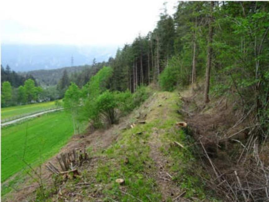
*Waalverlauf des 1539/50ers in Brunau mit einem Abschnitt, der in Richtung Norden geht. Wir befinden uns hier im Steilhang etwas unterhalb der Öztaler Bundesstraße. Auf der Hangseite wurde der 70x70 cm große Waal mit einem 180 cm hohen Wall abgesichert, der im Laufe der Jahre durch die Reinigung im Frühjahr entstanden ist. Je älter der Waal, desto höher der Wall.*
