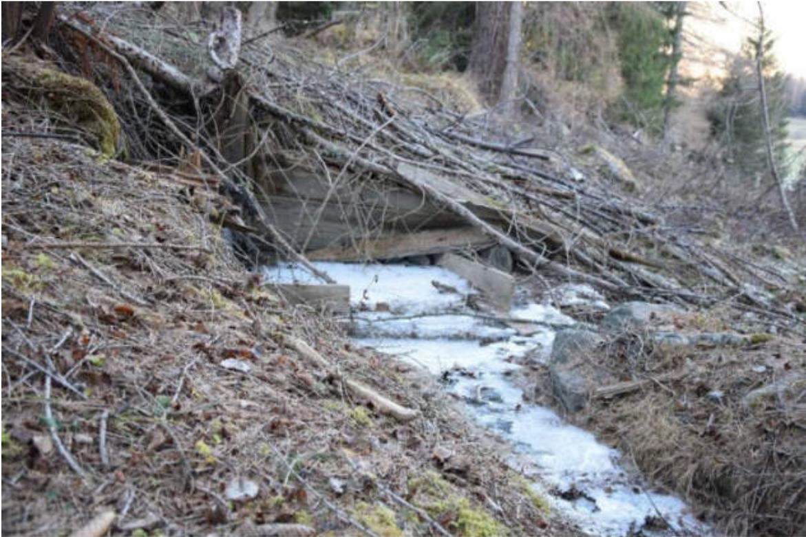
*Der ehemalige Schwölller (Schleuse mit Schiebern), der das Wasser einerseits in einen zweiten Nebenwaal und in die Auskehr, anderseits in den Unteren Zieha-Waal für die Bedienung von Schmiede und Sägemühle geleitet hat.*
