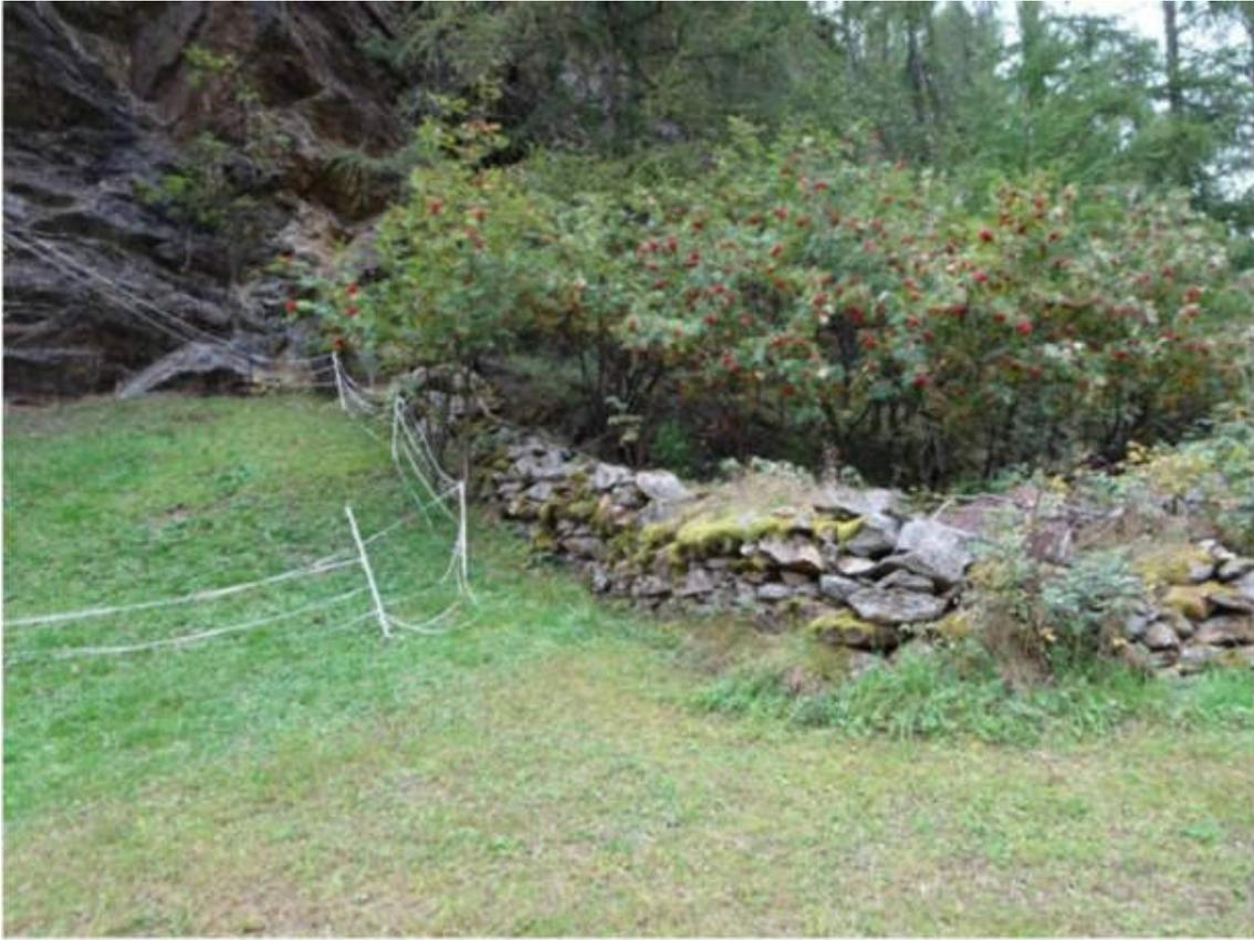
*An einigen Stellen des Granbichlwaales 1 bis 11 wurden die Hangwiesen mit wertvollen Trockenmauern abgesichert. Leider sind nicht alle in einem guten Zustand.*
