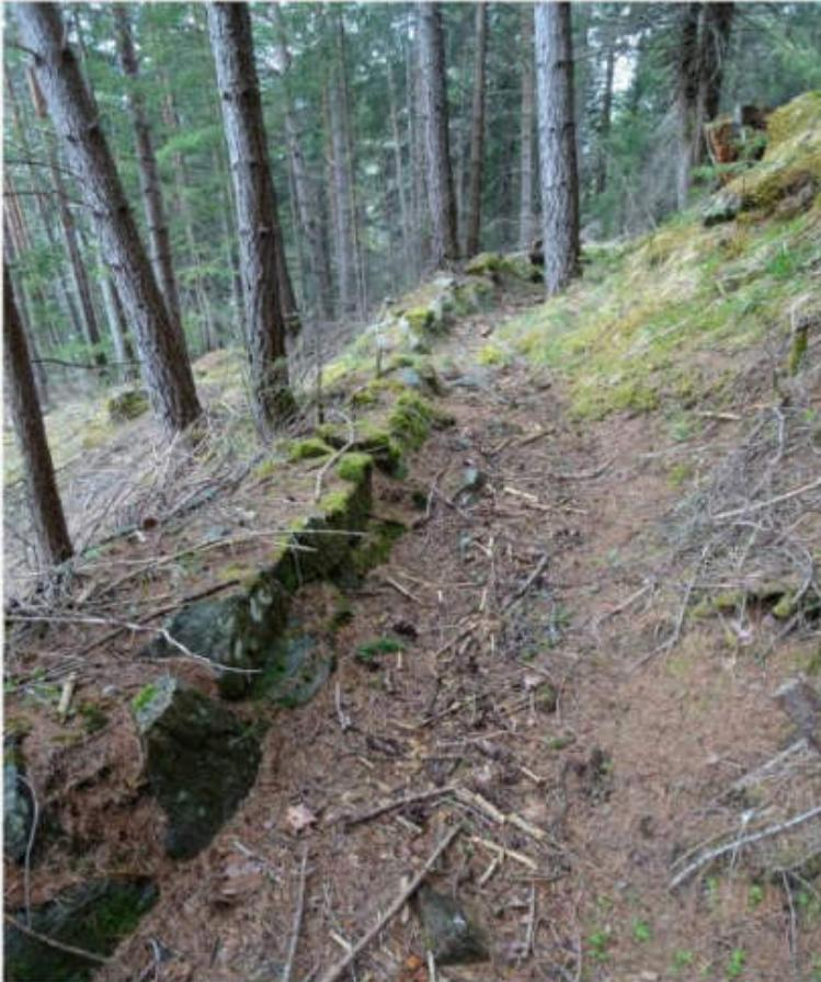
*Trockengemauertes Bauwerk auf der Hangseite, das mit organischem Material undurchlässig gemacht wurde.*
