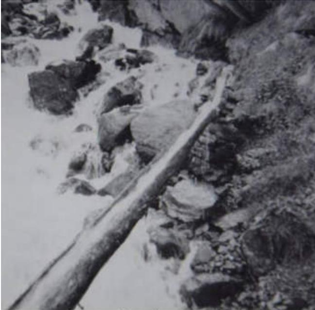
*Fig. 2 – Sölden im Ötztal. Wasser wird aus dem Rettenbach mit Hilfe einer hölzernen Rinne entnommen.*
