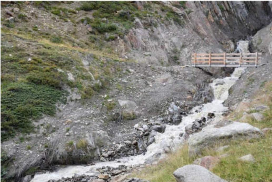
*Einkehrstelle des Piehlwaales 3 (Hauptwaal) am Vernagtbach. Hier wurde die Einkehr mit einer Kendl durchgeführt, weil der Vernagtbach als typischer Wildbach bei jeder Schneeschmelze und bei jedem Unwetter eine fixe und standardmäßige Einkehrvorrichtung zerstört hätte.*
