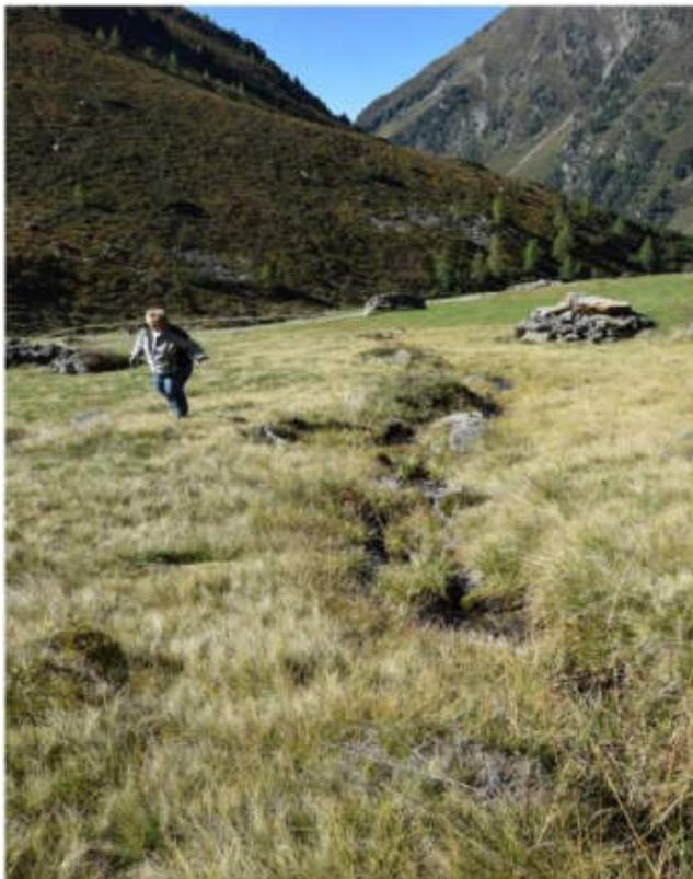
*Dieser Nebenwaal ist ein Runst, d.h. ein Waal, der mit schlangenförmigem Verlauf am Hang nach unten geht.*
