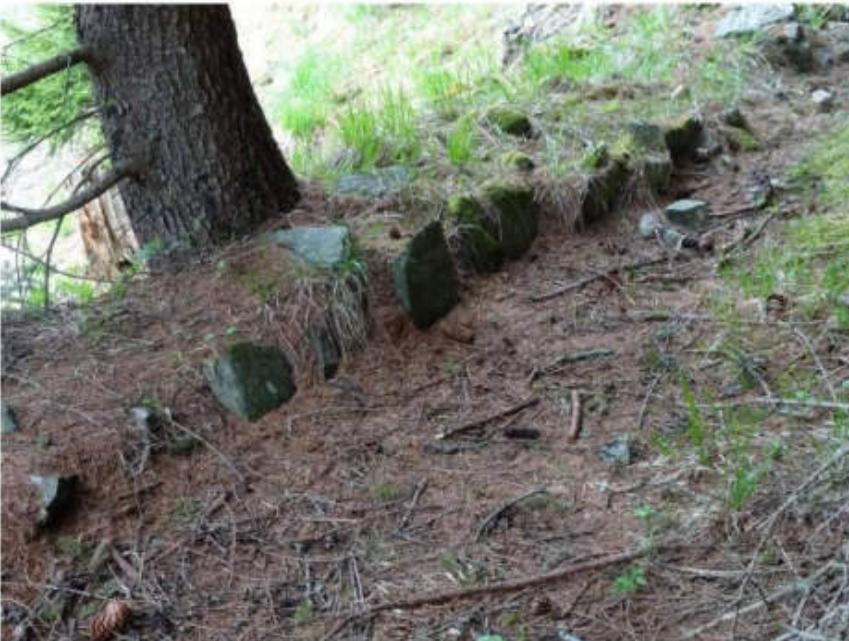
*Am Niederthaier Waal entdeckt man an mehreren Stellen trockengemauerte Abschnitte - eine vergessene Bautechnik.*
