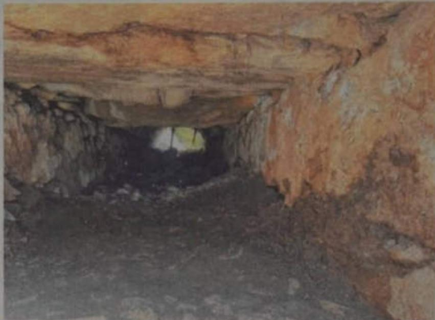
Eindrucksvolle Dimensionen: Der gemauerte, mit einer aufwändigen Steinkonstruktion abgedeckte Kanal dürfte in der Lage gewesen sein, rund 1000 Liter Wasser pro Sekunde weiterzuleiten.
