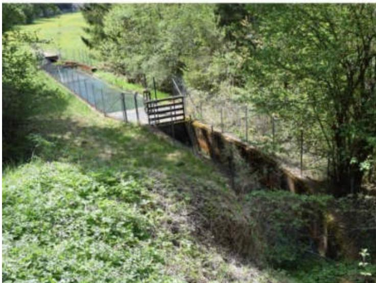
*Der Zubringerkanal verläuft 120 m unterirdisch, dann folgt das 36 m lange Sandbecken und schließlich der Kanal, der in den Stollen führt.*
