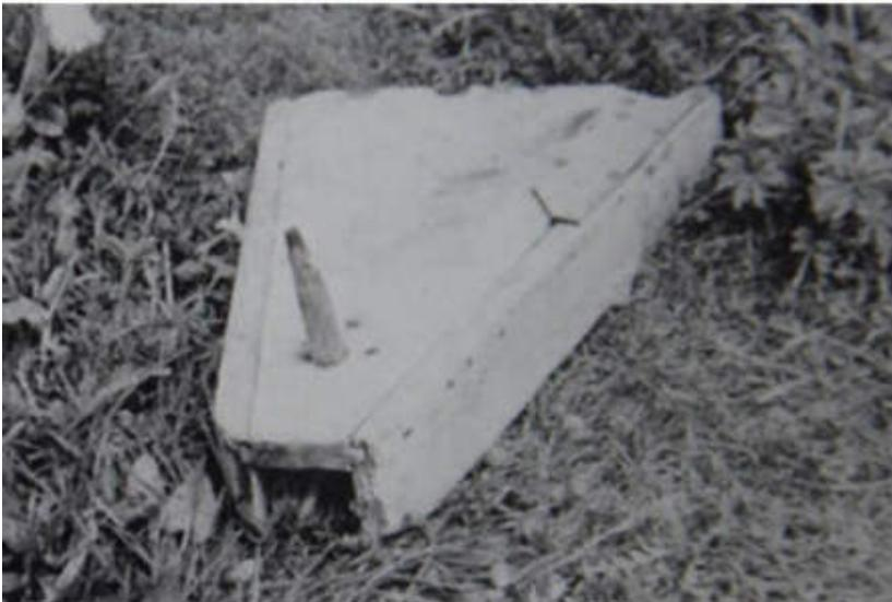
*Fig. 10 – Sölden im Ötztal. Unterseite des umgedrehten „Fangers“. Der hölzerne Pflock verhindert das Abrutschen des „Fangers“ am Hang.*
