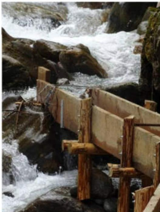
*Einkehr des Moosersteg-Waales an der Windache. Der sehr gut restaurierte Moosersteg-Waal wurde im Kapitel 4.6.1 (Quellen, 4.) genauestens beschrieben. Er wird in die Oberwindau-Waale ausgekehrt, die das Wässerwasser in Richtung Talboden brachten. Vom Mööswaal konnten keine Spuren gefunden werden.*
