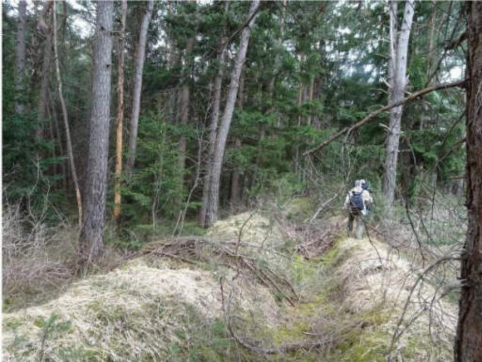
*Aufnahme 12. April 2018. Im Wassertal verlief der 1616er Waal mit zwei Wällen, die eine Höhe von 120 cm erreichen. Im Jahre 1952, als dieser Tragwaal aufgegeben wurde, hatte er ein Betriebsalter von 336 Jahren erreicht. Bei der jährlichen Reinigung im Frühjahr ist jeder Wall um ca. 1,5 mm in die Höhe gewachsen. Mit diesem Kriterium könnte man u.a. auch das Alter der großen Tragwaale abschätzen<sup>vi</sup>.*
