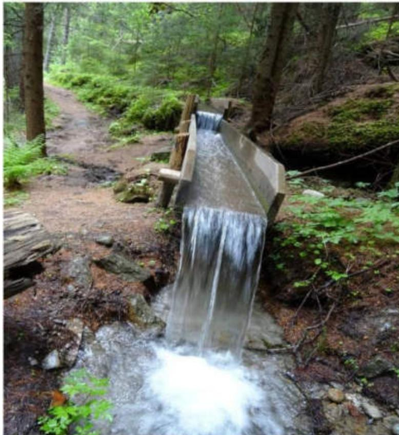
*Kahnen sind Bretterwaale, die in einer Werkstatt hergestellt wurden und bis zum vorgesehenen Waalverlauf transportiert werden mussten. Im Gegensatz dazu konnten Kandln an Ort und Stelle bearbeitet werden, ein gefällter Baumstamm wurde halbiert und ausgehöhlt.*
