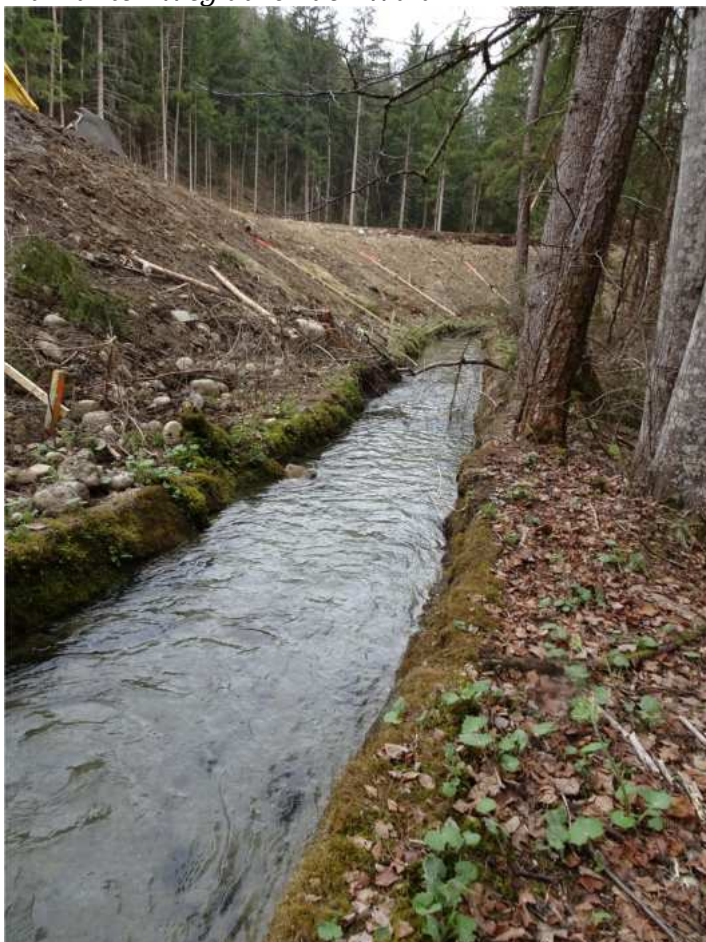
10. April 2018 – Der Tragwaal flankiert eine ehemalige Baustelle.
