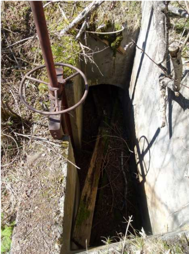
18. April 2018 – Einer der 6 Sandkästen mit Schieber, die Sand- und Sinkstoffe im Wässerwasser auf der Strecke zwischen Unterrain und Magerbach systematisch in den Inn ausgekehrt haben. Der Schieber ist zwar 93 Jahre alt, aber immer noch komplett und unter Umständen noch funktionsfähig.
