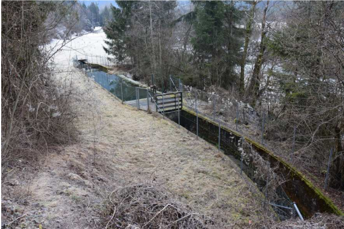
Aufnahme 03.01.2020 – Der Zubringerkanal vor der Renovierung.
