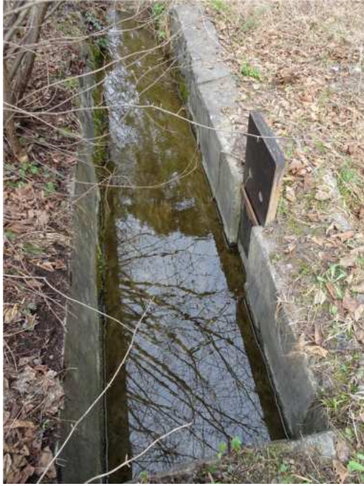
10. April 2018 – Der Haiminger Tragwaal setzt seinen Verlauf in einer betonierten Rinne entlang der Bundesstraße in Richtung Osten fort.
