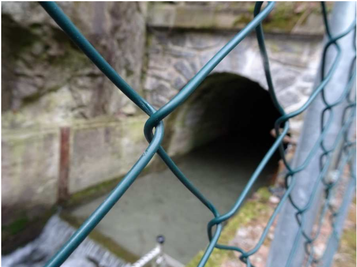
Aufnahme 10. April 2018. Der Stollenausgang des aktuellen Haiminger Tragwaales von 1947/52 – Der direkte Zugang zum Stollenausgang wird aus Sicherheitsgründen von einem Metallzaun verhindert.
