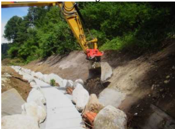
Bild #6 – Hinterfüllen der Wasserbausteine mit bindendem Zwischenboden und großem Bruchkies.
