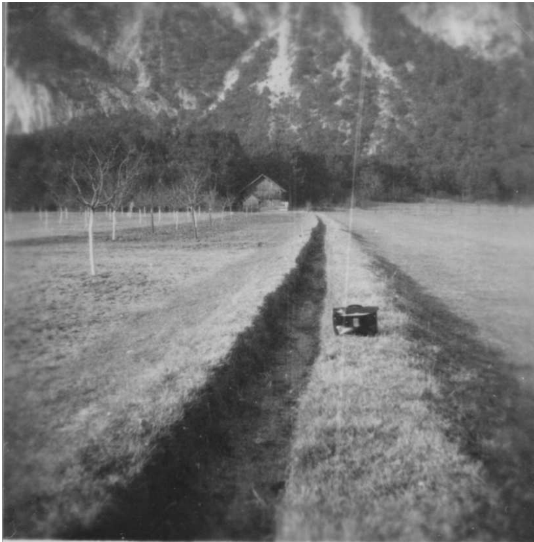
Fotoalbum Dr. Walter Zaderer 1950 – Der Tragwaal nach dem ersten Verteiler bei Magerbach. Er erreichte eine Gesamtlänge von 5,21 km.
