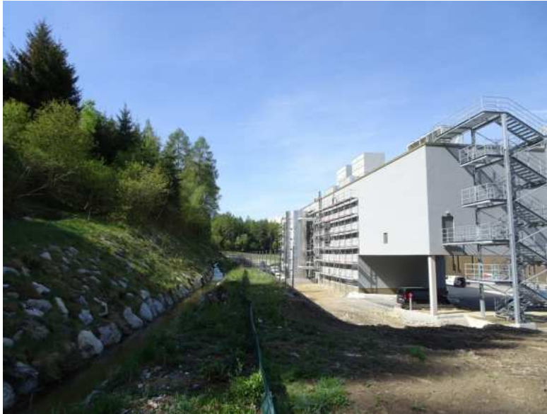
25. April 2018 – Der Waal führt hinter dem Fabriksgebäude vorbei und wird mit einem Zaun abgesichert.
