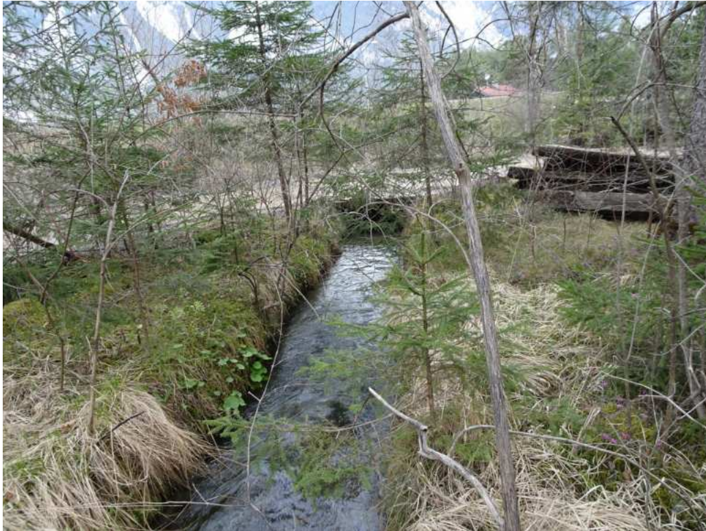
10- April 2018 – Der Haiminger Tragwaal verläuft geradewegs in Richtung Norden, unterquert den Fuhrweg mit einer Dole und gelangt schließlich am südlichen Rand der Bundesstraße zum Schwöller.
