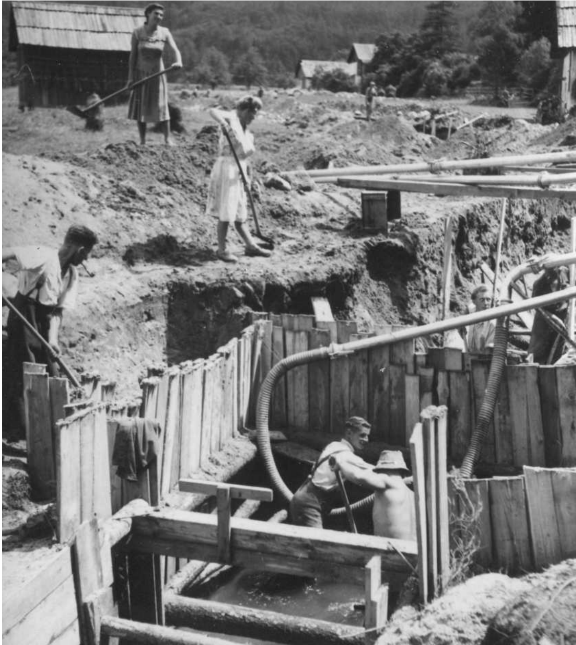
Aus dem Haiminger Gemeindearchiv – Bau des Zubringerkanals (1947-49). Wegen fehlender Arbeitskräfte nach dem 2. Weltkrieg wurden auch Frauen für Schwerarbeiten herangezogen.
