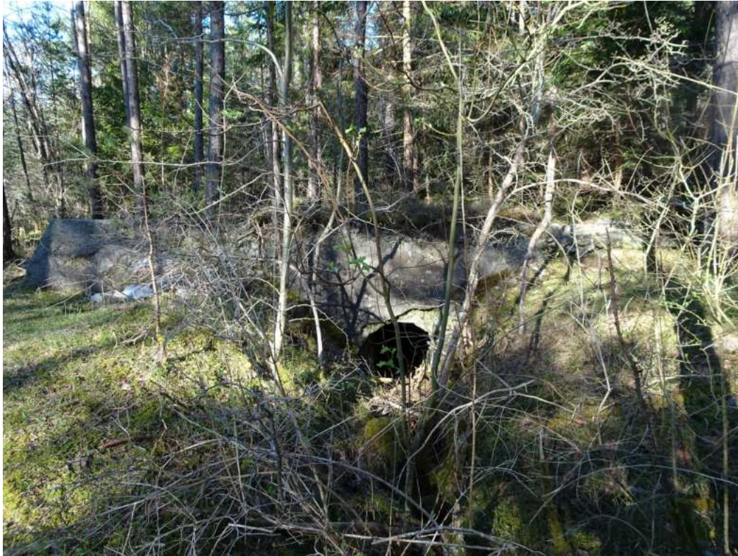
18. April 2018 - Betonierte „Murenunterführung“ in Schlierenzau. Muren sind und waren immer schon die größten Feinde offen verlaufender Waale. Um den immer wieder vorkommenden Schäden entgegenzuwirken, wurden Dolen oder ganze Stollen gebaut, wie in diesem Fall.
