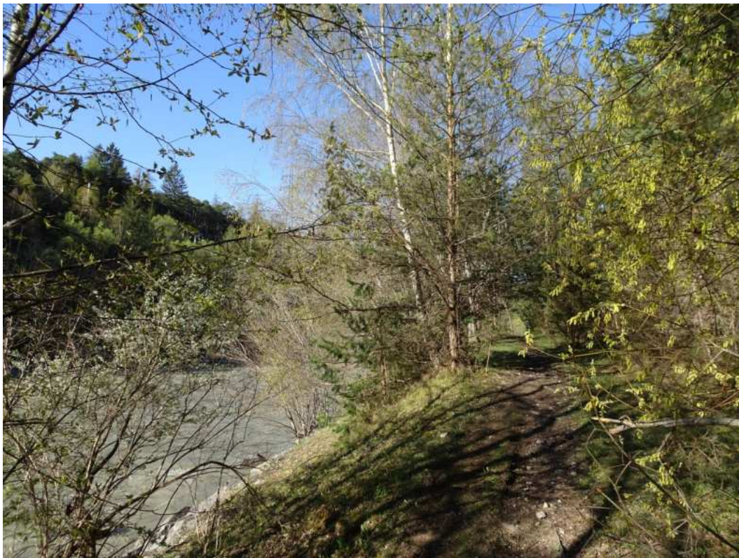
18. April 2018 - Richtung SW, auf der Suche nach der Einkehr 450 m oberhalb der Einmündung der Öztaler Ache. Hier verlief einst der Schlierenzauer Tragwaal, der mit Erde zugedeckt wurde und somit zu einem „Waalweg am Inn“ geworden ist.
