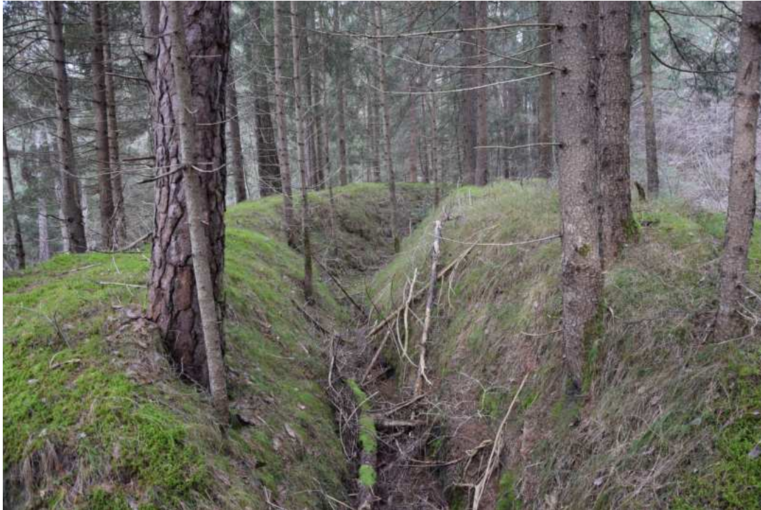
03.01.2020: oben in Richtung Norden (Wall 210 cm hoch), unten in Richtung Süden.
