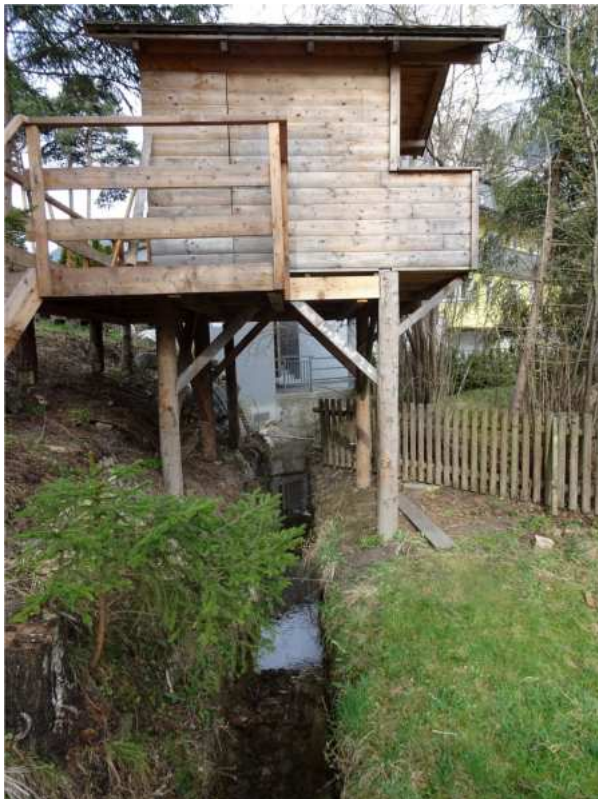
10. April 2018 - Der Riederer Waal verläuft hier am Rande eines privaten Wohnhauses und die Familie hat eine Holzhütte gebaut, die wie ein kupferzeitlicher Pfahlbau über dem Waal steht.
