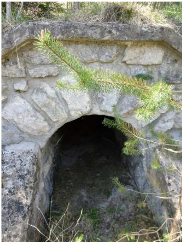
18. April 2018 – Einer der 6 Sandkästen mit Schieber, die Sand- und Sinkstoffe im Wässerwasser auf der Strecke zwischen Unterrain und Magerbach systematisch in den Inn ausgekehrt haben. Der Schieber ist zwar 93 Jahre alt, aber immer noch komplett und unter Umständen noch funktionsfähig.
