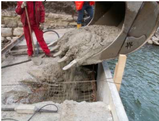
Behebung des Schadens mit Eisenbeton.
