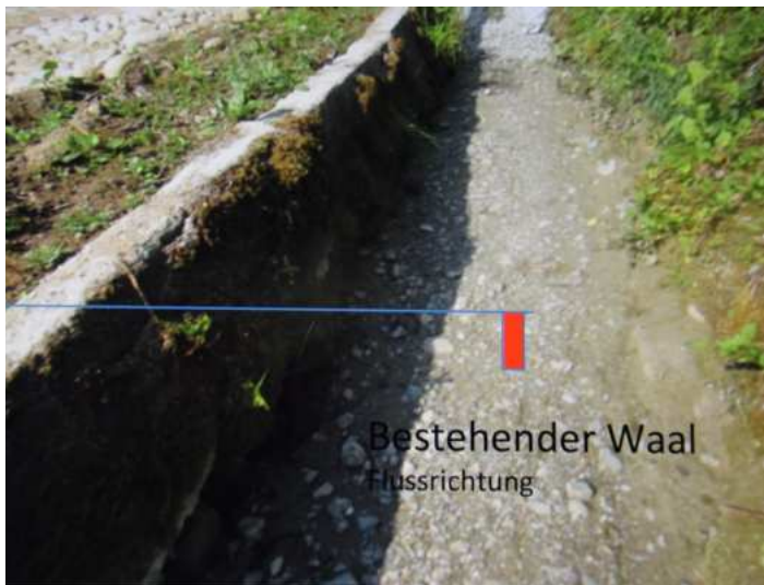
Bild #1 – Entfernung des bestehenden Waales.
