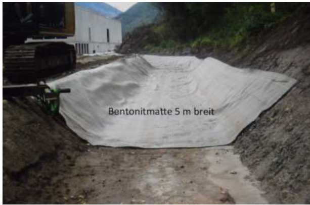
Bild #3 – Abdichtung der Waalsole mit einer Bentonitmatte.
