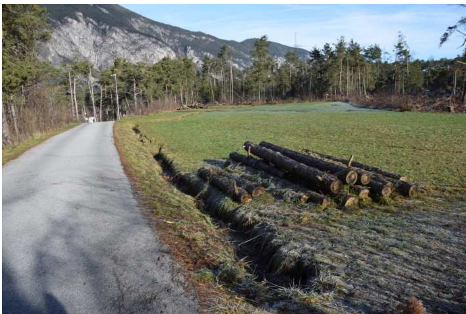
27.12.2023 – Mit einer Dole unterquert der Waal die Straße und verläuft Richtung Wald.
