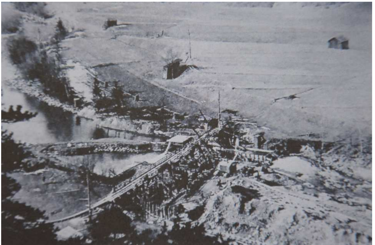
Bild der Baustelle in Brunau vom Winter 1947/48, zur Verfügung gestellt von Herrn Hermann Lunger aus Längenfeld.
