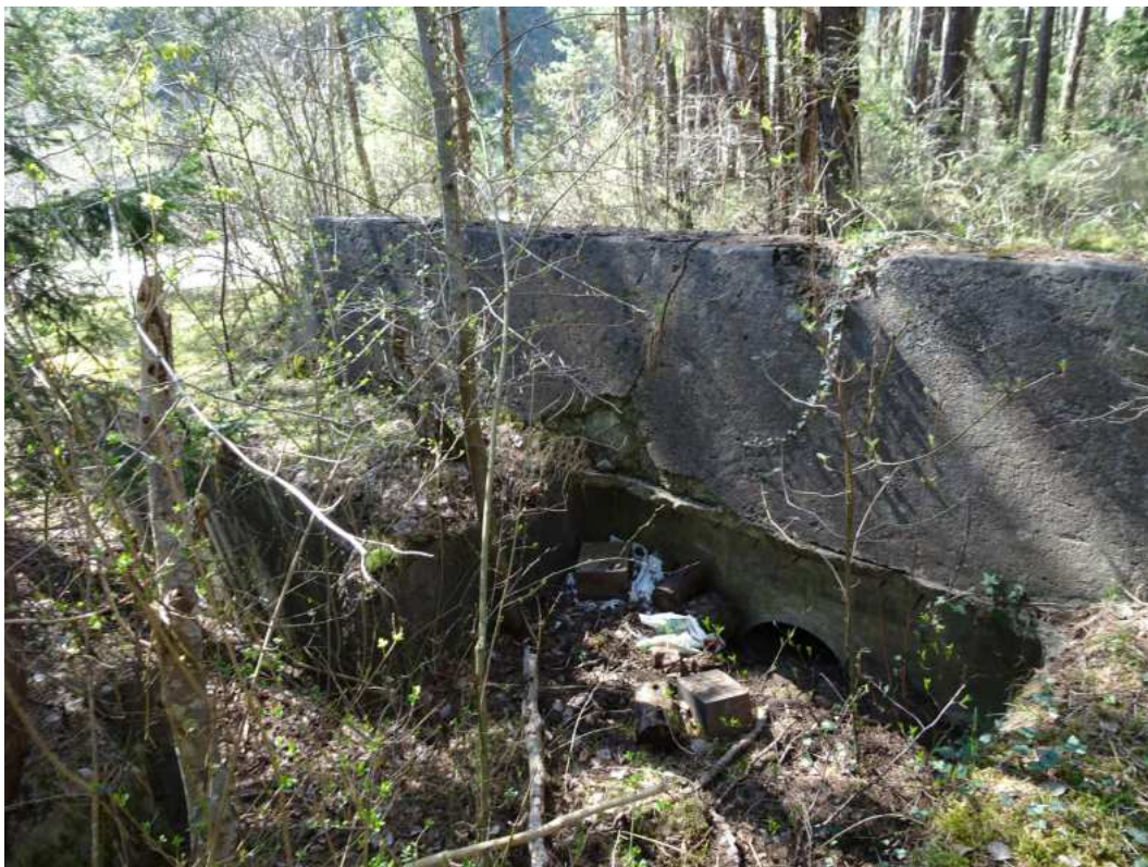
18. April 2018 – Eine zweite betonierte Murenunterführung. Das Rohr hat einen Durchmesser von 1,10 m, der Waal zieht offen gerade weiter in Richtung NO. Eine Auskehr mit einer Breite von 1,10 m führt nach rechts (links im Bild) zum Inn hin. Die zugelassene Leistung des Tragwaales beträgt 126 l/s – theoretisch wären aber mehr als 700 l/s möglich!
