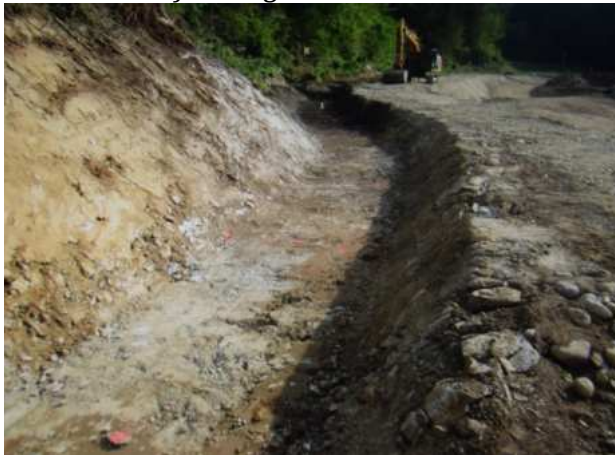
Bild #2 – Ausbesserung und Neustrukturierung der Waalsohle.
