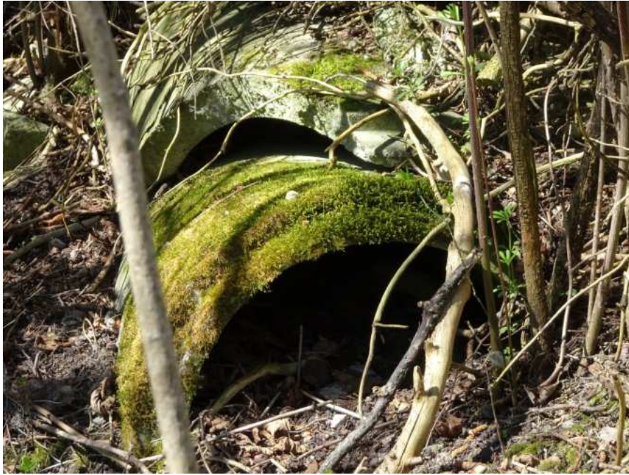
18. April 2018 – Herumliegende Betonrinnen im Gestrüpp.
