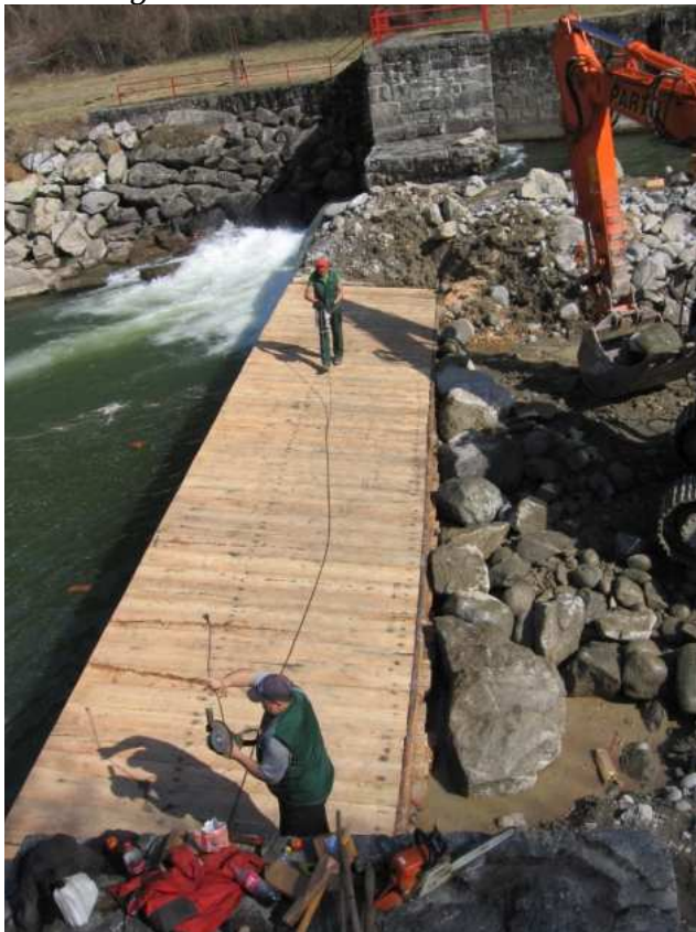
Für den Wehrbelag wurden hölzerne Balken verlegt, das Wasser konnte wieder zugeleitet und für den üblichen Verlauf freigegeben werden.
