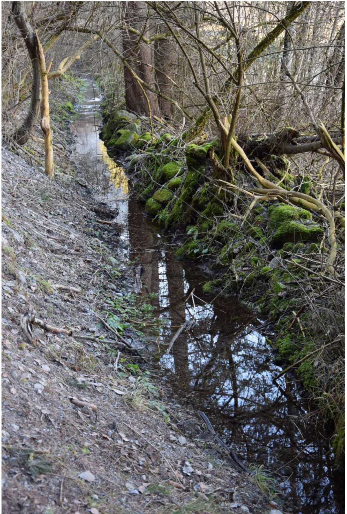
Aufnahme Frühjahr 2024 – Der Brunauer Mühlwaal ist durch Holzablagerungen schwer beschädigt worden (siehe Chronologieachse).
