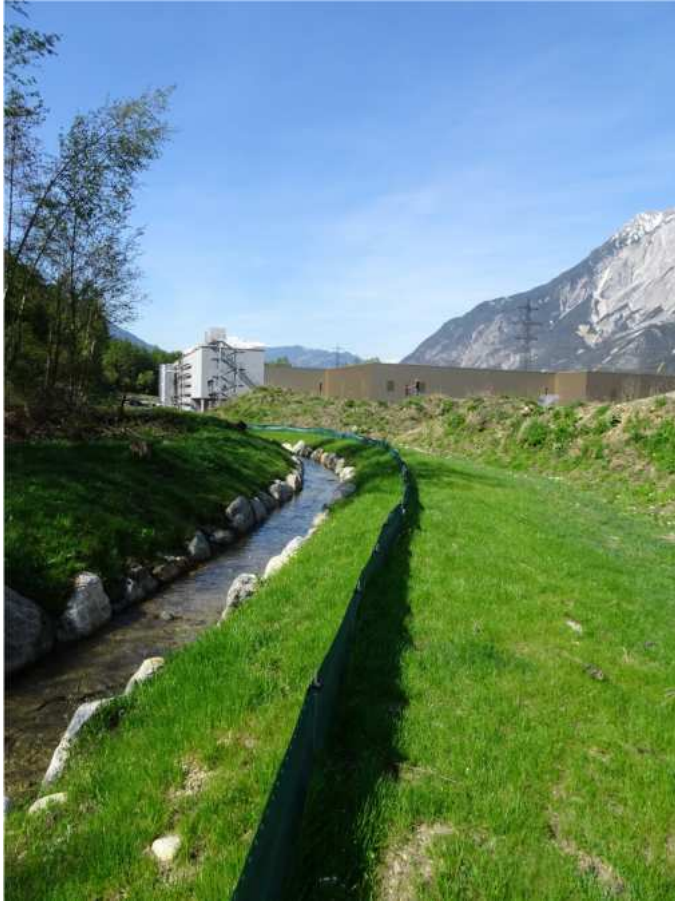
25. April 2018 - Hier endet das erste Projekt der Renovierung, die im Jahre 2017 begonnen wurde.
