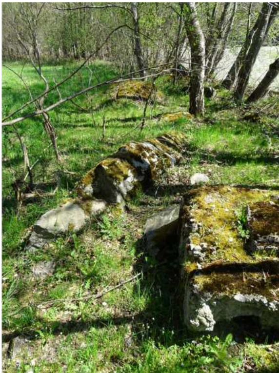
18. April 2018 - Sandkasten Nr. 5 am Ende des Schlierenzauer Tragwaales. Die Waalspur ist teilweise noch ziemlich gut erkennbar.
