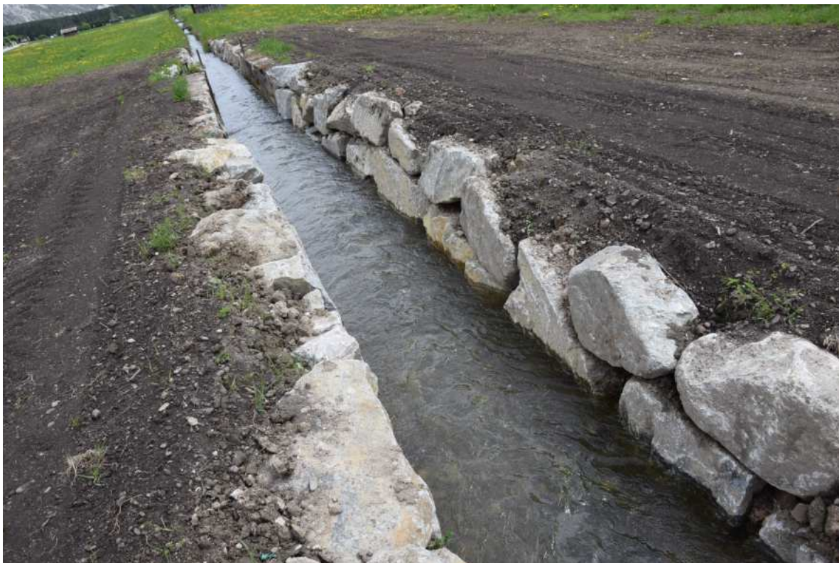
Mai 2019 - Blick gegen Osten. Der Tragwaal, der mit großen Steinen abgedichtet wurde, ist wieder in Betrieb.
