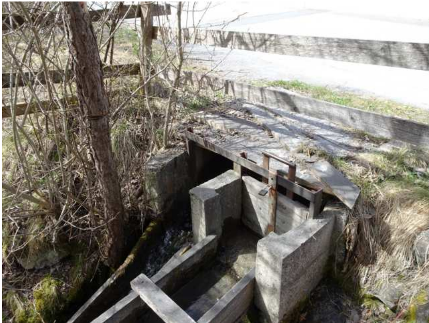
9. April 2018 - Hier wird das Wasser vom Mühlwaal in die hochgestelzte Kahne geleitet, die das Wasser bis zum Mühlrad führt. Eine derartige Vorrichtung nennt Walter Zaderer ABLASS, Hans Paul Menara SCHWÖLLER, Andreas Schöpf (aus Ried i.O.) KOMMANDER und Josef Hammerle (aus Serfaus) KARMANNA.
