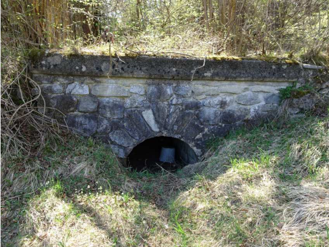
18. April 2018 – Ein weiterer gemauerter Stollenausgang. Ab hier verlief der Waal offen.
