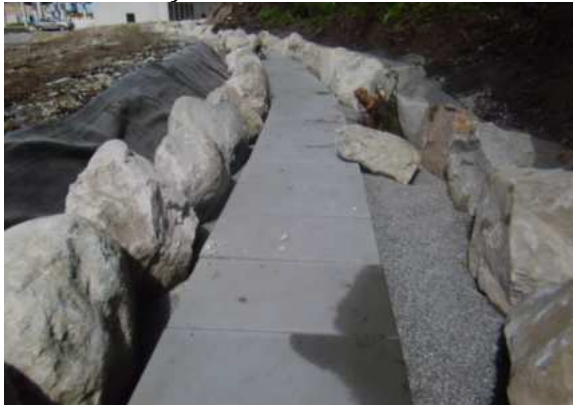
Bild #5 – Strukturierung der Seitenwände mit Wasserbausteinen.
