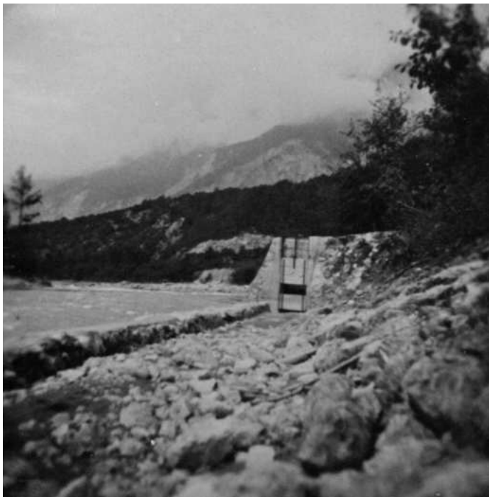
Fotoalbum Dr. Walter Zaderer – Aufzugschleuse, linkes Innufer in einer Rechtskurve.
