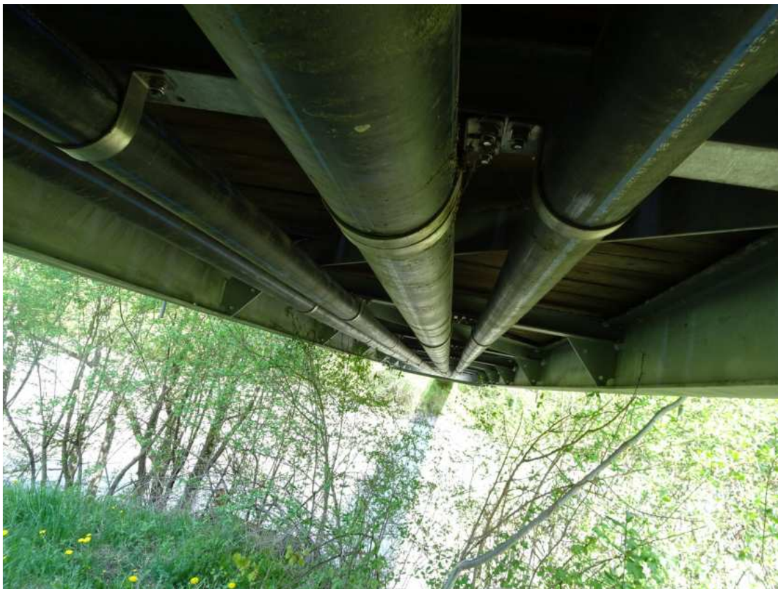
25. Mai 2019 - Mit einer Rohrleitung, die an der Unterseite der Hängebrücke befestigt ist, wird das Wässerwasser über den Inn transportiert.
