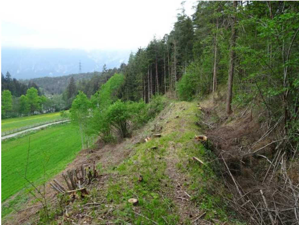
Aufnahme 4. Mai 2018. Die Abmessungen ergaben 70x70 cm. Der Wall, auf dem der Waalweg verlief, erreicht an dieser Stelle eine Gesamthöhe von 160 cm.
