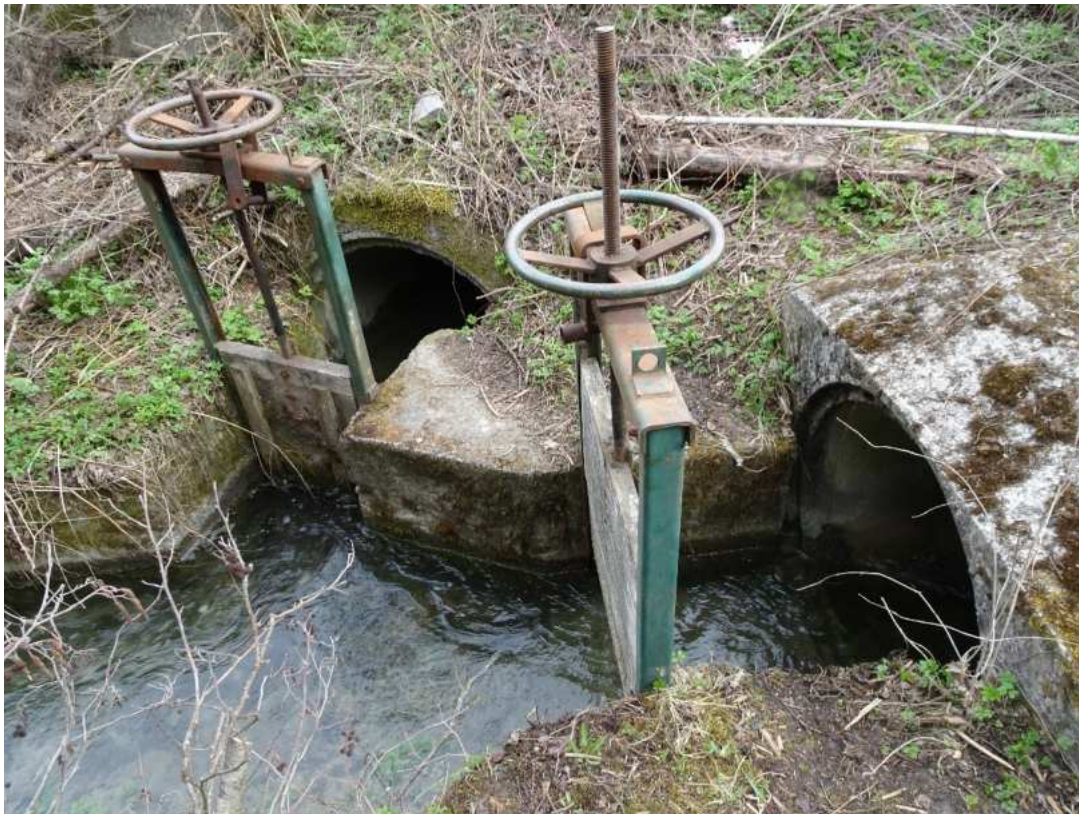
Aufnahme 10. April 2018 – Links der Schieber für den Haiminger Mühlwaal, rechts jener für den Haiming-Silzer Tragwaal. Ein perfektes System, wie man es in Tirol leider nur mehr selten zu sehen bekommt.
