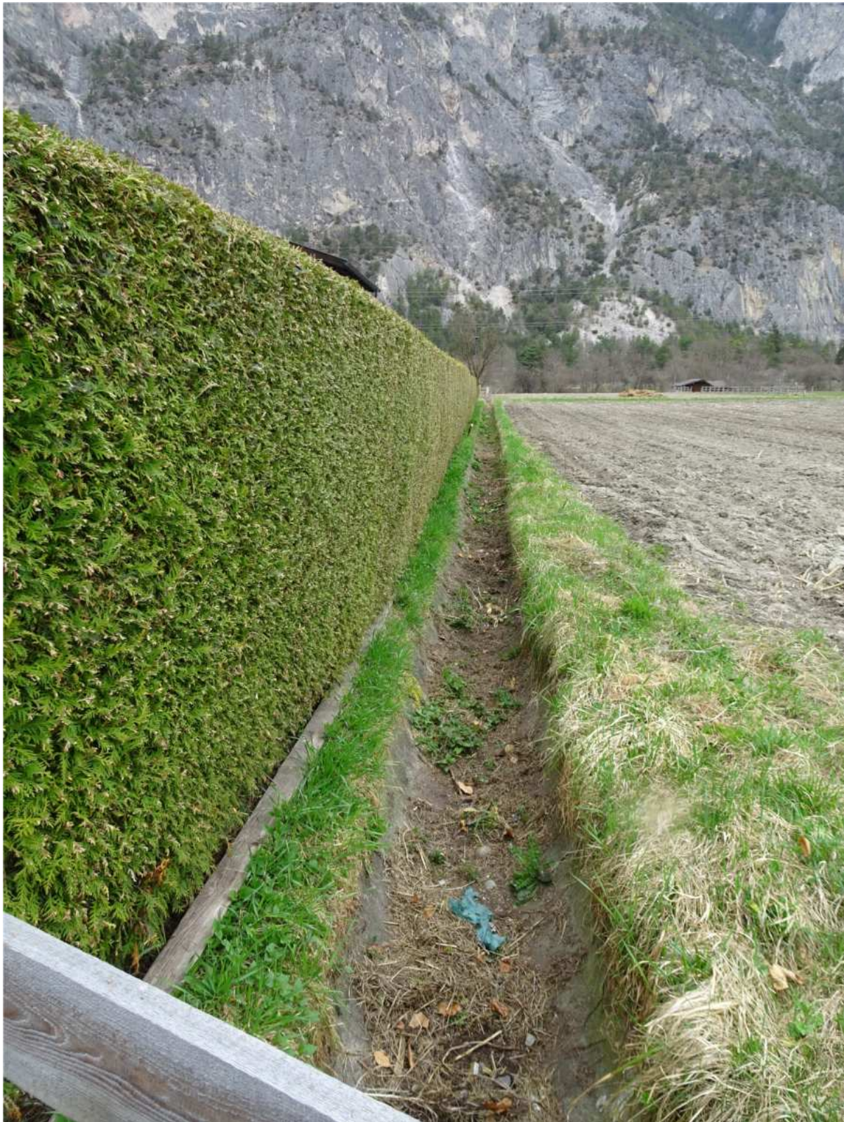
April 2018 - Mit dem überhöhten Rand auf der linken Seite des Waales kann das Wasser auf die Wiese rechts vom Waal geleitet werden, bis die Flur völlig überschwemmt ist. Ein derartiges Bewässerungsverfahren nennt man „Stauberieselung“. Wenn das Wasser eine Höhe von 20 cm erreicht hat, wird der Zufluss abgesperrt und gewartet, bis das Wasser in den Boden gesickert ist. Dann kann die Stauberieselung wiederholt werden.
