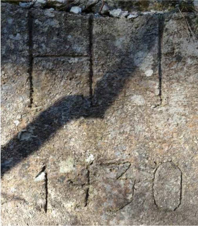
18. April 2018 – Das in den Beton eingeritzte Jahr 1930. Da Projektunterlagen nicht mehr zugänglich sind, ist es schwierig, das Jahr 1930 zu bestätigen. Aber wegen der Bauart und aufgrund der historischen Voraussetzungen dürfte das eingeritzte Jahr ziemlich genau zutreffen.
