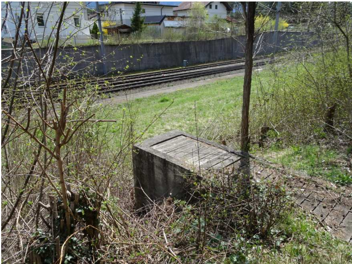
10. April 2018 - Mit einem Düker d unterfährt der Riederer Waal die Bahnlinie.
