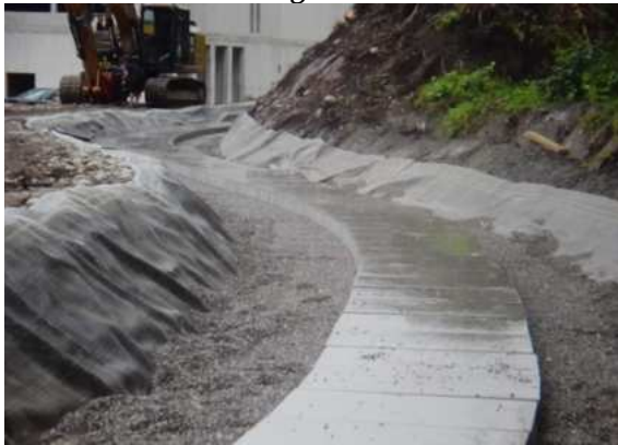
Bild #4 – Einfüllen des Kiesbettes und Verlegung der Betonplatten mit 05% Gefälle.
