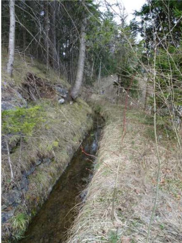
10. April 2018 - Hier ist der Waal 60 cm breit und 38 cm tief. Der Waal könnte an dieser Stelle eine Leistung von theoretischen 171 l/s erreichen.
