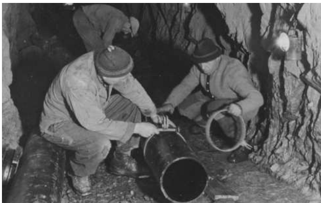
Aus dem Haiminger Gemeindearchiv – Arbeiten im Stollen im Jahre 1951 mit Verlegung der Trinkwasserleitung (80er Rohr).
